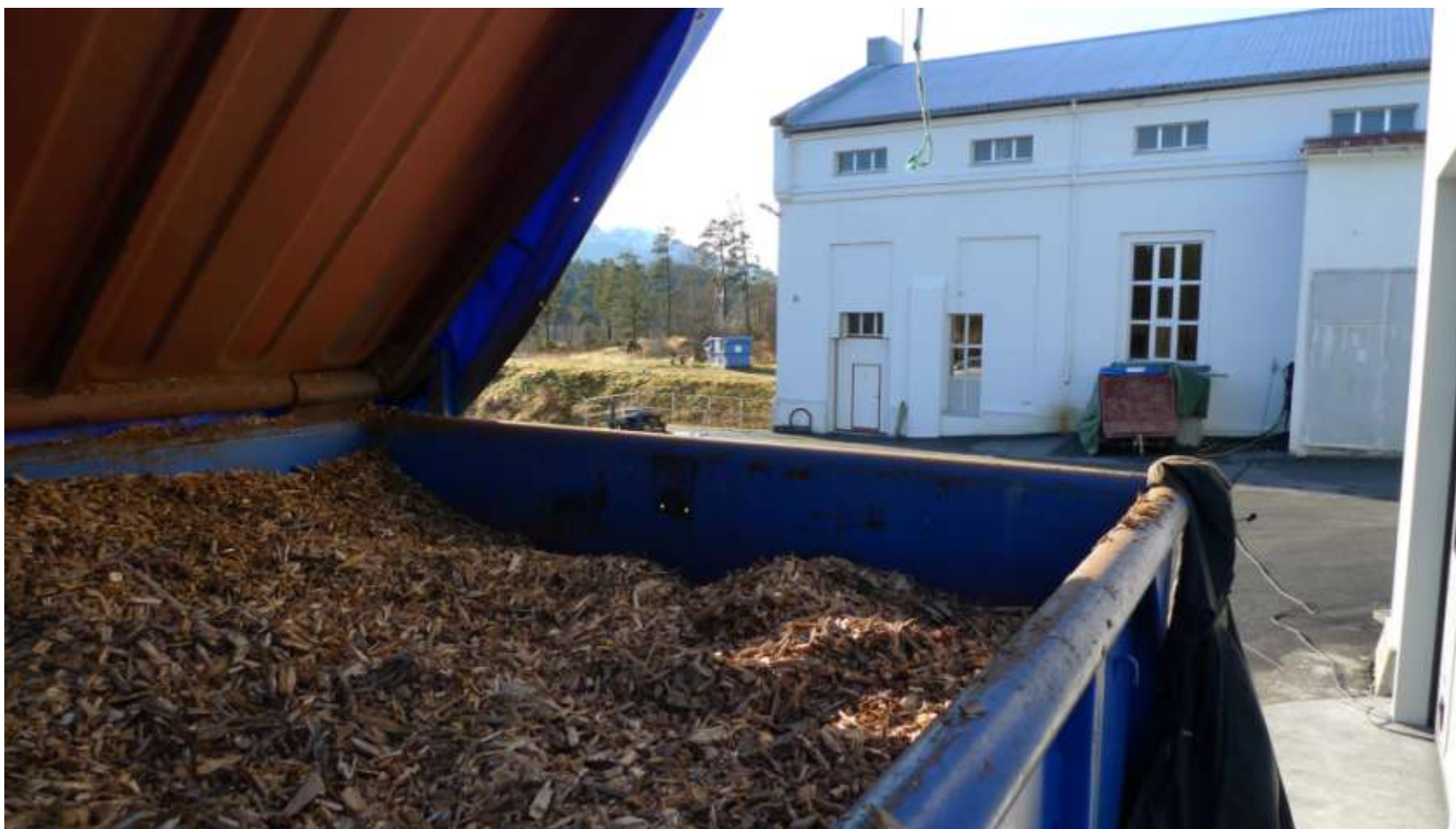
Istad kraftstasjon på Kleive, installert effekt 2200 kW.
